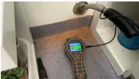
Hulltaking i vegg bakenfor dusjsone.
