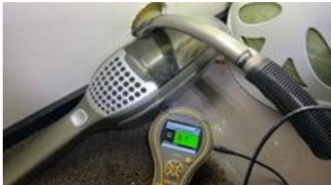
Hulltaking i gang i underetasje.
