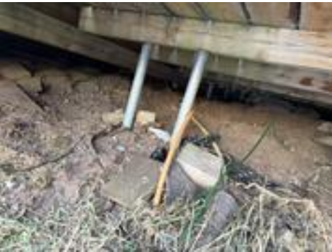
Provisoriske støtter under vinterhagen.
