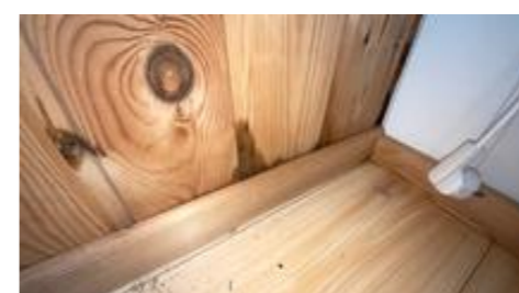
Fuktskjolder i trepanel ned mot gulv i soverommet
