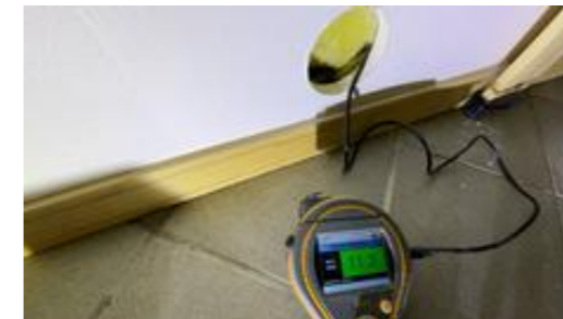
Hulltaking er foretatt i vegg mot grunnmur i bod.
