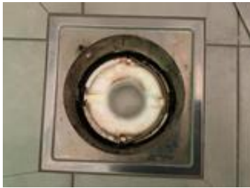
Oversiktsbilde av sluk.
