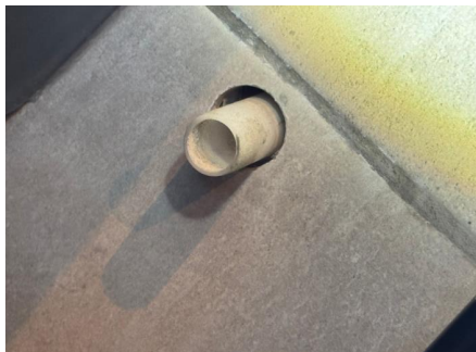
Utett gjennomføring.
