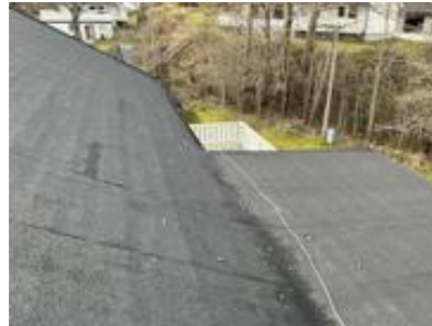
Tak tekket med asfaltpapp.
