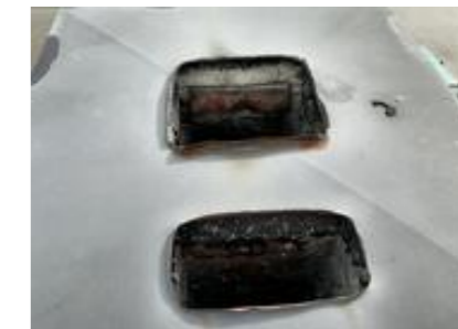
Manglende toppavdekning over pipe.
