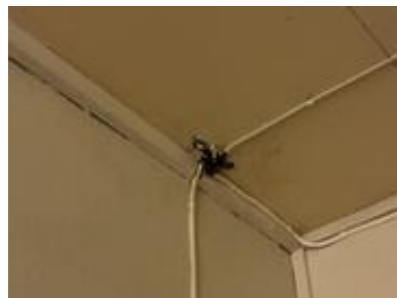
Ledninger/koblinger uten deksel/koblingsboks.
