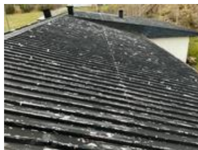
Tak tekket med lakkerte/malte takplater.
