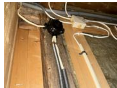
Koblingsboksen med innhold av asbest.
