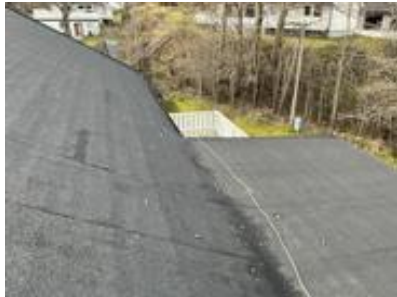
Tak tekket med asfaltpapp.
