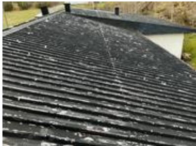
Tak tekket med lakkerte/malte takplater.
