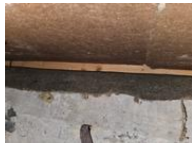
Undersiden av bjelkelaget er kledd med porøse trefiberplater
