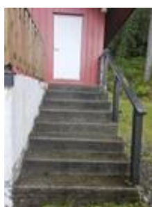
Trapp av betong til inngangspartiet
