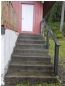
Trapp av betong til inngangspartiet
