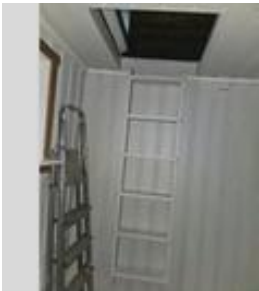
Adkomst til hemsen via fast montert stige på veggen
