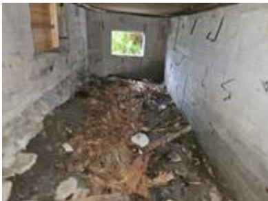
Krypkjeller under bakre del av hytta. Mye rester av organisk materiale på gulvet.
