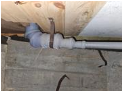
Avløpsrør av plast, her fra sluken på badet
