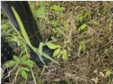
Takkvannet ledes til rør i grunnen
