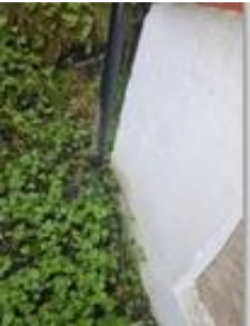
Takkvannet ledes til terrenget ved grunnmuren
