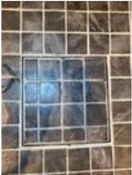
Fliser har løsnet fra slukrammen
