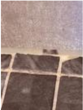
Fliser har løsnet fra slukrammen
