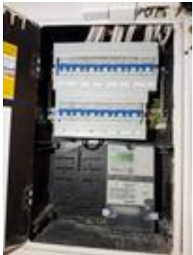
Automatsikringer med skap i felles nabogang.
