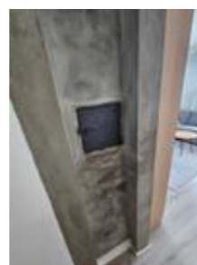
Mursteinspipe og sotluke på stuen
