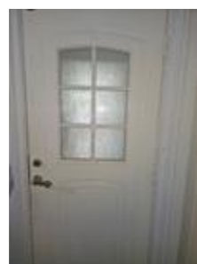
Ytterdør mellom leiligheten og trapperommet
