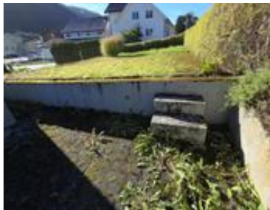
Trapp opp til uteområde på garasjetak.
