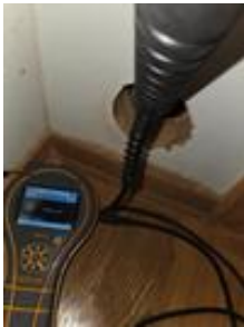
Hulltaking og fuktmåling i vegg mot bad.
