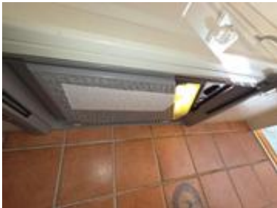
Funksjonstestet ved befaring.
