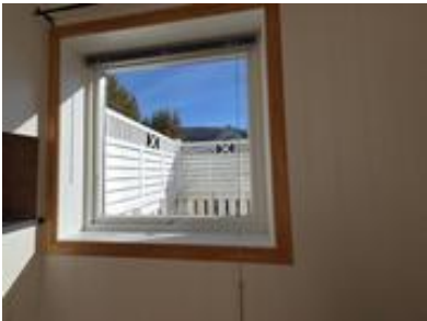
Malte trevinduer med 2-lags isolerglass.
