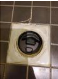
Tettesjiktets tilslutning til sluk - Gulvsluk
