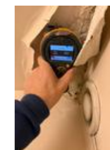
Kontrollert med fuktindikator. Ingen unormale utslag.
