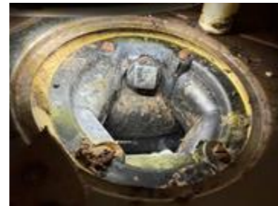
Originalt sluk med rustne skruer
