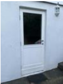
Dør mot bod / yttergang underetasje
