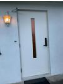
Hoveddør sokkelleilighet. Av nyere type
