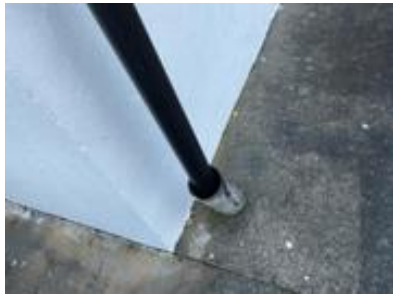
Takvannet ledes til rør i grunnen
