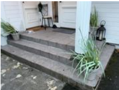
Tre trappetrinn opp til inngangspartiet
