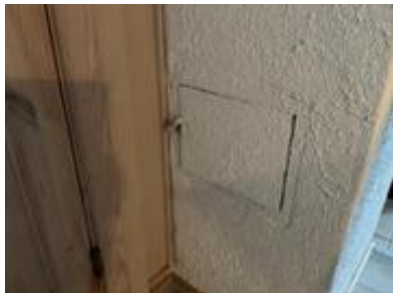
Sotluken er plassert mindre enn 30 cm fra brennbart materiale
