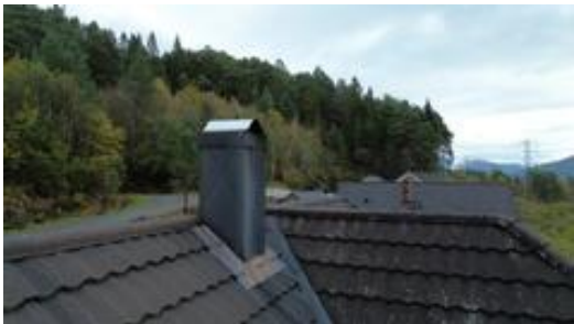
Pipetrekk av metall
