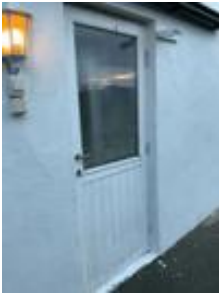
Dør mot soverom under terrasse
