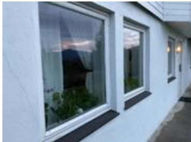
Vinduene har karmen av tre og isolerglass
