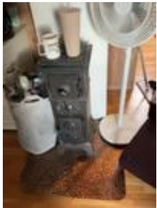
Sotluken er plassert mindre enn 30 cm fra brennbart materiale
