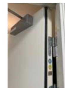
Klassifisert entredør med dørpumpe
