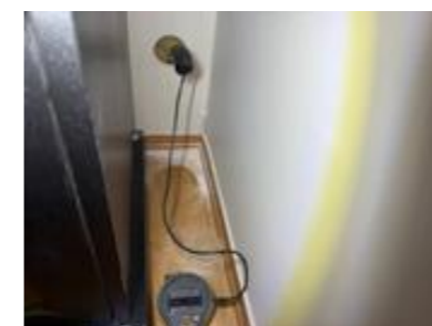
Hulltagning med pigger i svill uten unormale utslag til hovedbad
