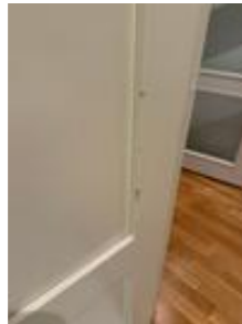
Bruksmerker på innerdører/karmer stedvis
