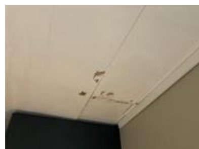
Skader etter tidligere lekkasje
