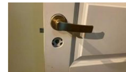
Eksempel på at deksel mangler.
