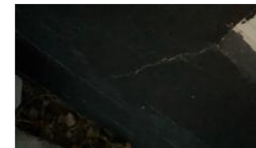
Eksempel på sprekk i grunnmur.
