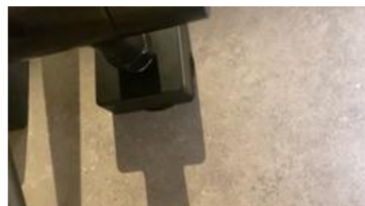
Deksel dekker ikke hull i flis.
