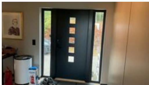
Hovedytterdør med glassfelt og elektrisk kodelås fra Yale Doorman.
