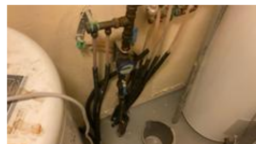
Vannledninger av plast (rør i rør).
