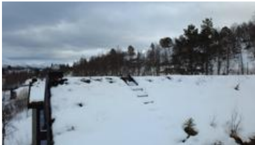
Taket er tekket med torv
