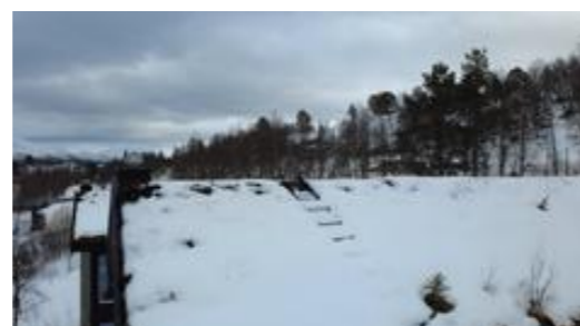
Taket er tekket med torv
