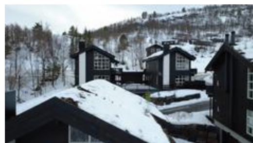
Taket er tekket med torv
