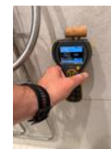
Ingen unormale utslag med fuktindikator på dusjvegger
