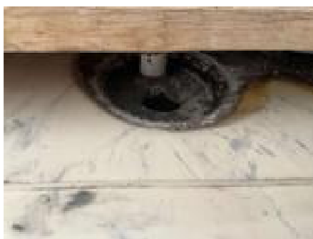
Oversiktsbilde av sluk.
