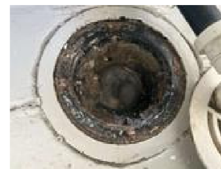
Oversiktsbilde av sluk.
