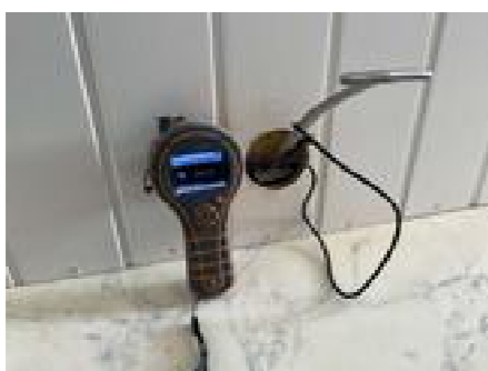
Fuktmåling uten utslag
