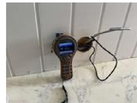
Fuktmåling uten utslag.
