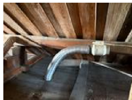
Avtrekk avsluttet på kaldtloft.
