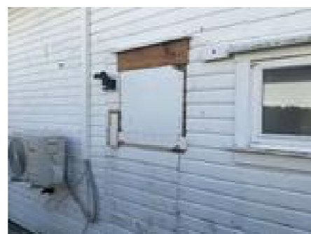
Vindusåpning tildekket med treplate
