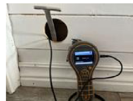
Fuktmåling uten utslag.
