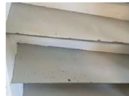
Hakk/skraper i trappe trinn.
