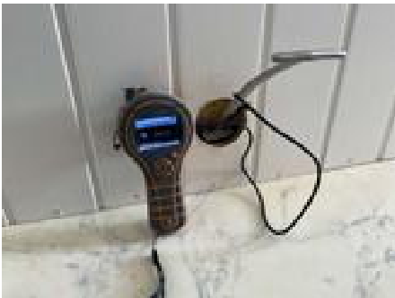
Fuktmåling uten utslag
