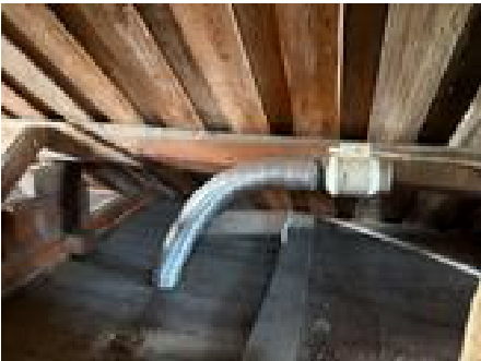
Avtrekk avsluttet på kaldtloft.
