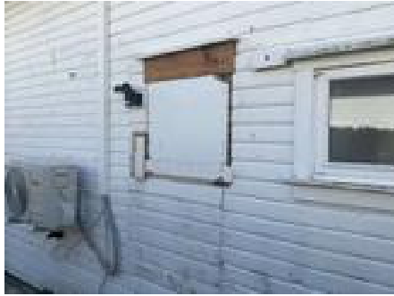
Vindusåpning tildekket med treplate
