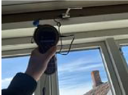
Tørr fuktmåling i råteskadet treverk.
