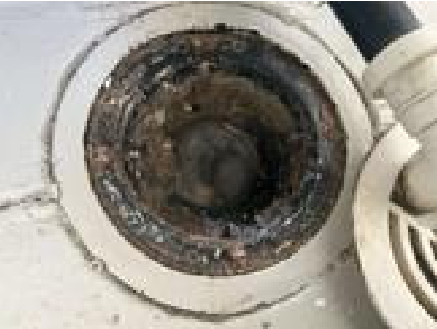
Oversiktsbilde av sluk.
