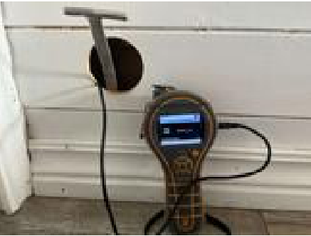
Fuktmåling uten utslag.
