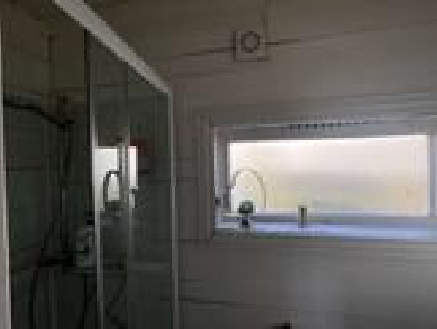
Vindu plassert i dusjens våtsone.
