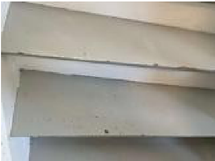
Hakk/skraper i trappe trinn.
