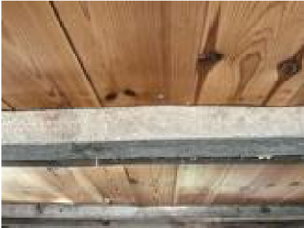
Spor etter borebiller i synlig bjelke,
