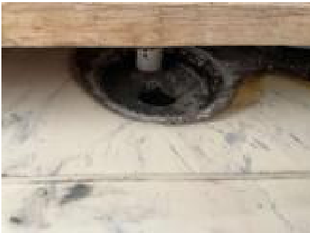
Oversiktsbilde av sluk.
