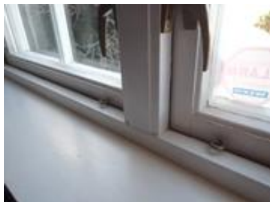
Innvendig malingsavskalling/slitasje
