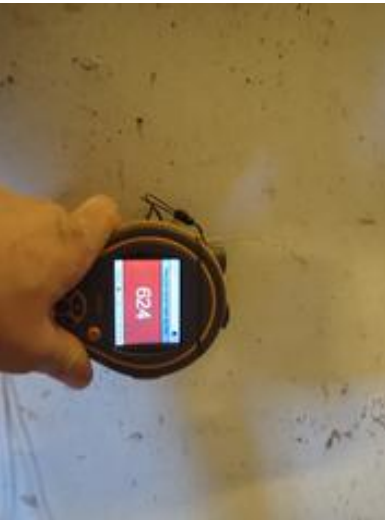
Fuktmåling på grunnmur.
