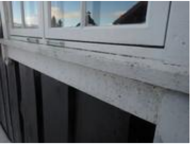
Sverting ved omramminger utvendig.
