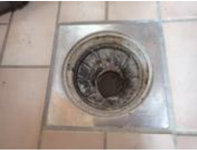
Bilde av sluk.
