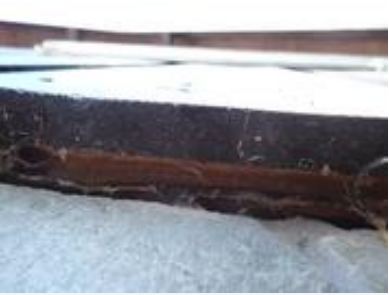
Oversikt oppunder kledning.
