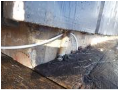
Skadet trekkerør.
