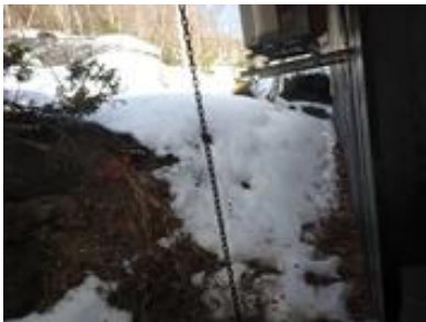
Terrenget faller mot bygningen på baksiden.
