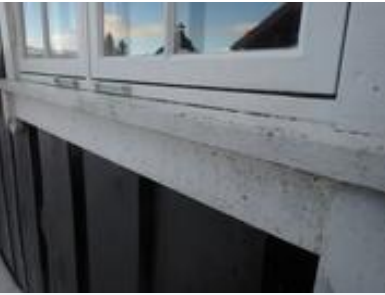
Sverting ved omramminger utvendig.
