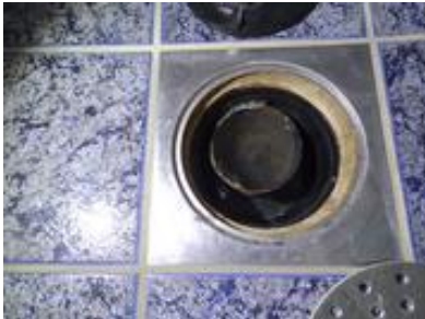
Bilde av sluk.
