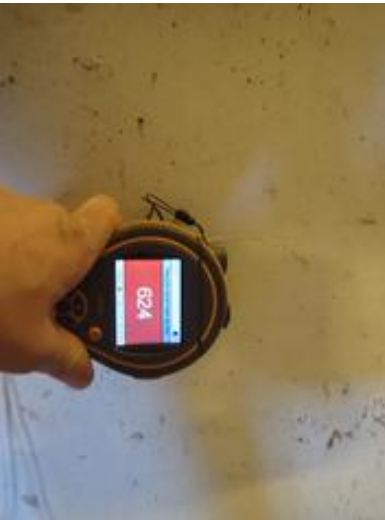
Fuktmåling på grunnmur.
