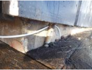
Skadet trekkerør.
