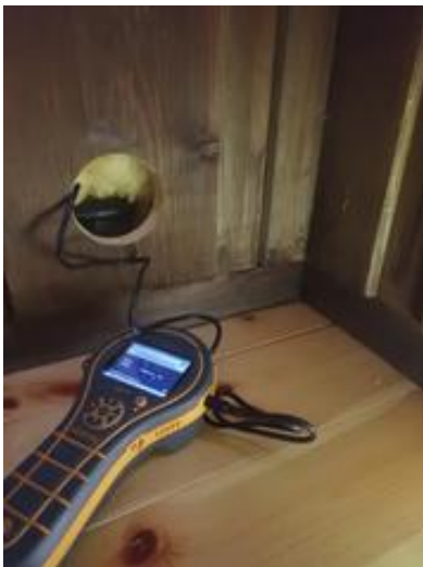
Ingen fukt ved måling i vegg.
