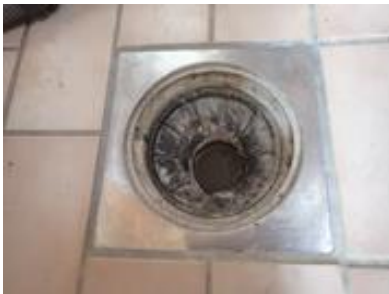
Bilde av sluk.
