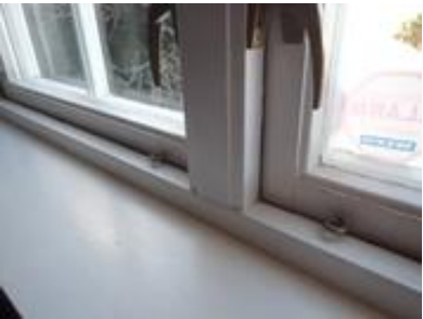
Innvendig malingsavskalling/slitasje
