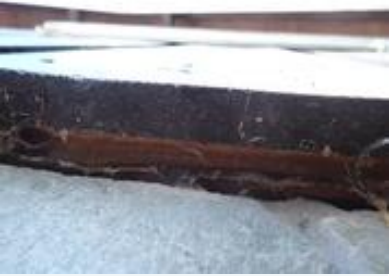
Oversikt oppunder kledning.
