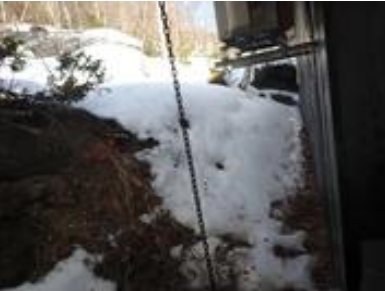
Terrenget faller mot bygningen på baksiden.
