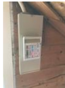
Sikringskap med automatsikringer
