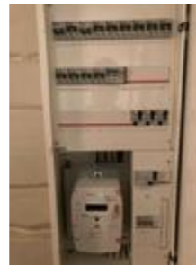
Sikringskap med automatsikringer
