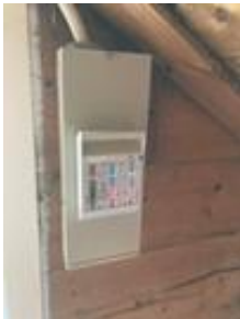
Sikringskap med automatsikringer
