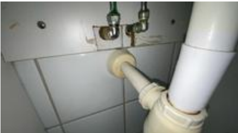
Utette rørgjennomføringer.
