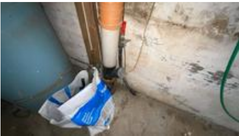
Stakeluke i kjeller.
