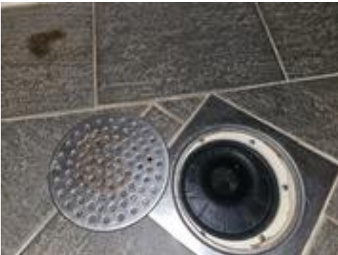
Plastsluk med mansjett og klemring
