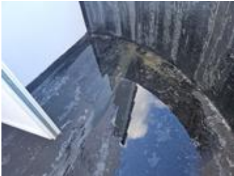
Det samler seg litt vann på dekket
