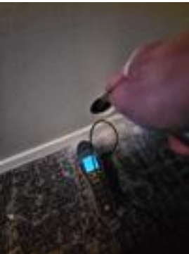
Ingen indikasjon på fukt i vegg
