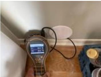
Målingen regnes som tørr og viser en relativ luftfuktighet på 64% ved 22 celsius.
