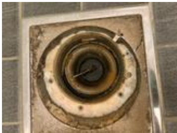
Oversiktsbilde av sluk.
