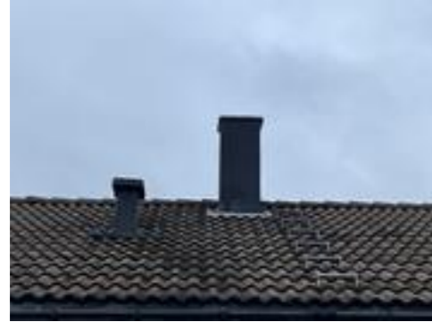
Hel beslått pipe og lufter hatt over tak.
