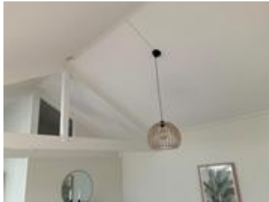
Takkonstruksjon kledd inne på innside.
