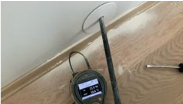
Fuktsøkt i vegg uten unormale forhold.
