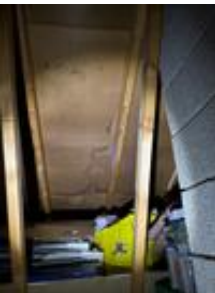
Fuktmerker fra tidligere i undertak kaldloft
