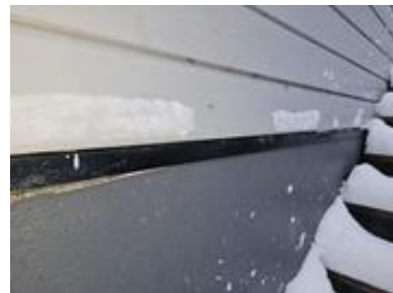
Lite lufting langs nedre kant av bordkledningen
