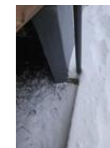
Takvann ledes til terrenget ved grunnmuren
