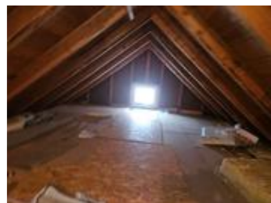
Kryp loft, delvis med gulv. Vindu i gavlene.
