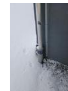
Takvann ledes i rør i grunnen
