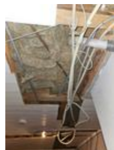
Oppussing i underetasjen er ikke helt ferdigstilt
