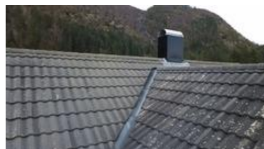
Taket er tekket med profilerte metallplater
