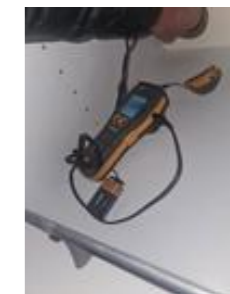
Ingen indikasjon på unormal fukt i vegg
