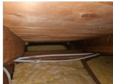
Isolert skrå takflate, med luftspalte
