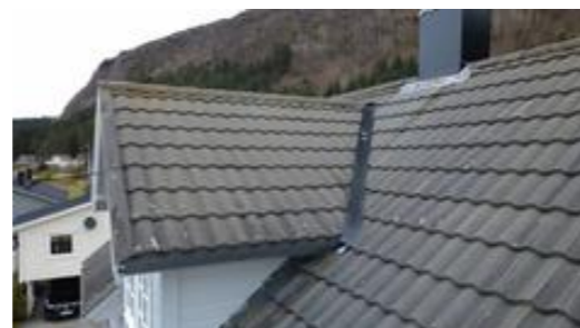
Taket er tekket med profilerte metallplater
