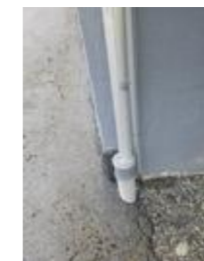
Takvannet ledes til rør i grunnen
