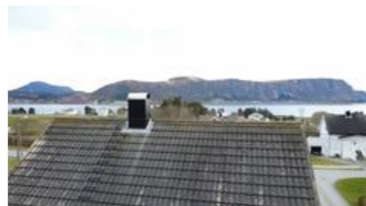
Taket er tekket med profilerte metallplater
