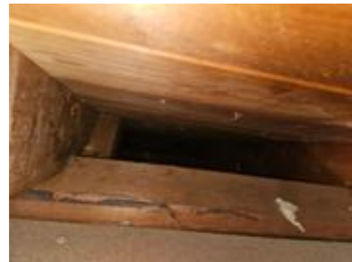
Uisolert skrå takflate
