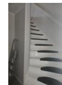
Innvendige trapper av tre mellom etasjene.
