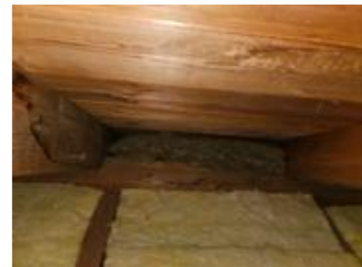
Isolert skrå takflate, uten luftspalte
