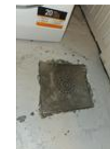
Sluk av eldre type. Ikke membran i rommet
