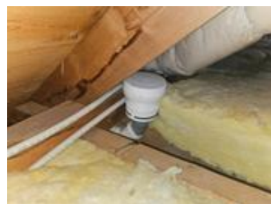
Membranventil på loftet
