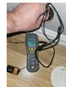
Ingen indikasjon på unormal fukt i veggen
