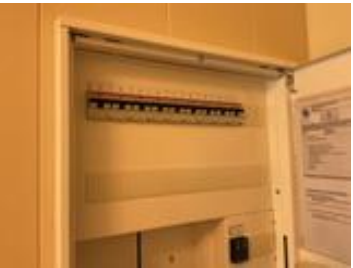
Sikringsskap med automatsikringer.
