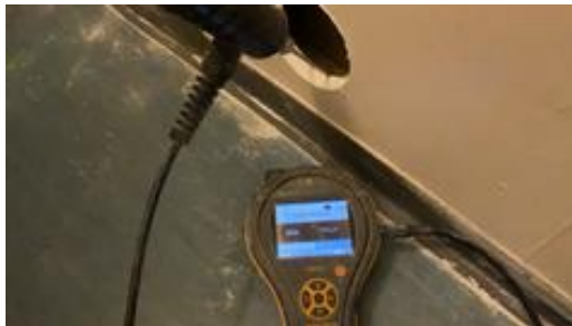
Fuktsøkt i vegg uten unormale forhold.
