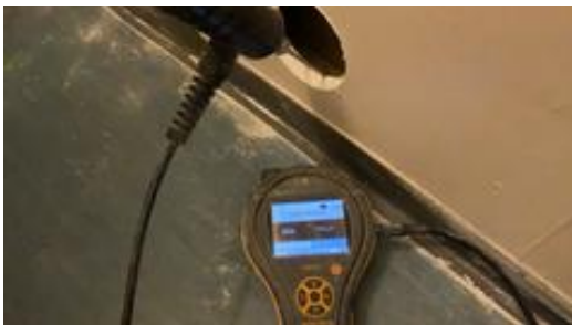
Fuktsøkt i vegg uten unormale forhold.
