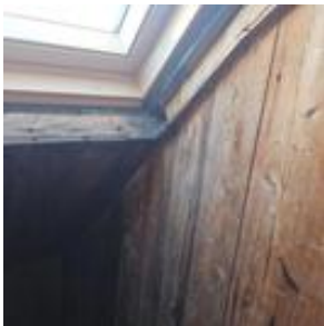
Tak av sperrer med undertak av tro / bord
