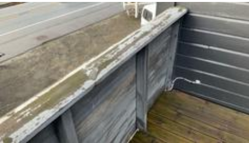
Malingsavflassing på rekke
