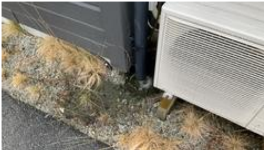
Nedløp fra garasje til terreng.
