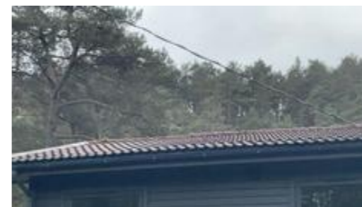
Betongtakstein av eldre årgang.
