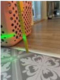
Overgang gulv mellom vaskerom og gang
