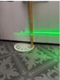
Sluk under skap ved vaskemaskin
