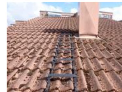
Eksempel på stedvis mose på tektekking/takstein.
