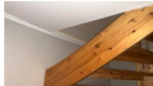
Trappen mangler noe rekkverk. Her må det sikres, slik at barn ikke kan krype igjennom.
