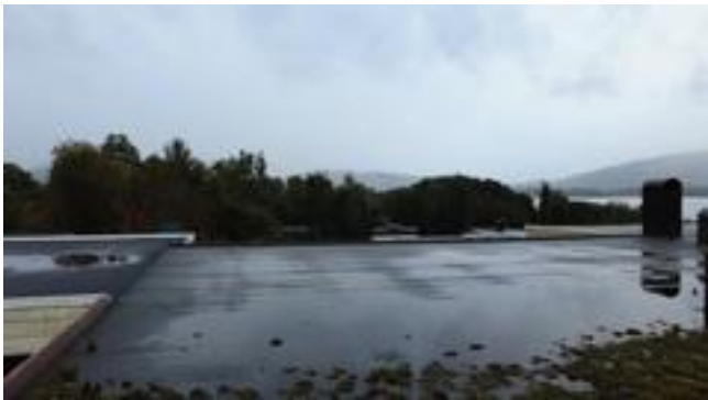
Taket er tekket med asfaltpapp
