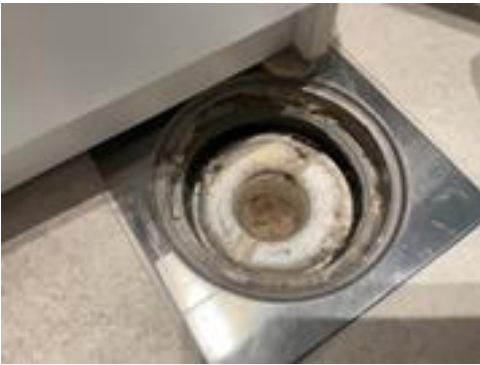
Plastsluk med slukmansjett og klemring
