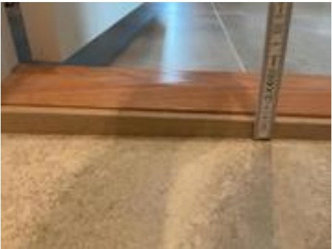
Membranen har en oppkant foran døren, skjult bak terskellisten
