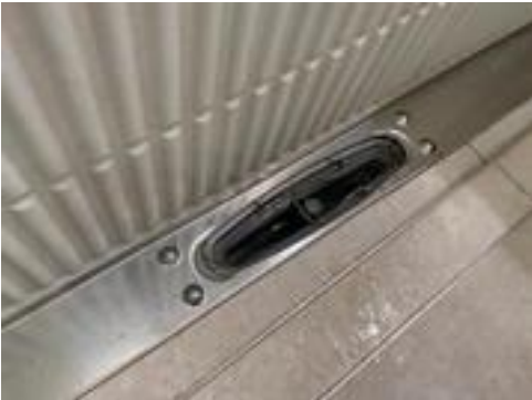
Slukrenne i dusjen. Slukmansjett og klemring.
