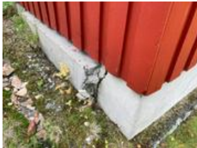
Sprekk i mur (overgang)
