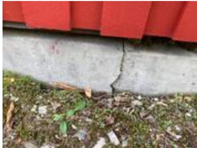
Sprekk i mur (overgang)
